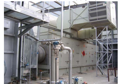
燃机二期项目实景图
